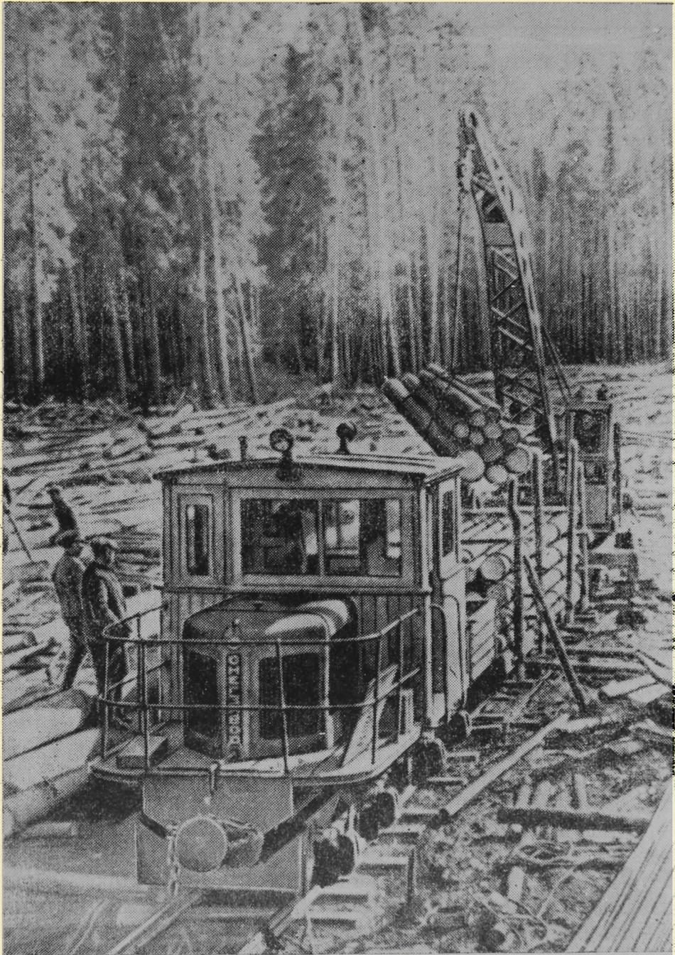
Механизированная погрузка древесины автокраном на Мысовском ЛДП,
